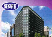
博多グリーンホテル(1号館)
